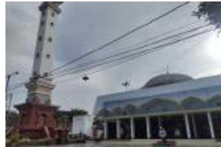
Kondisi Bangunan Masjid
