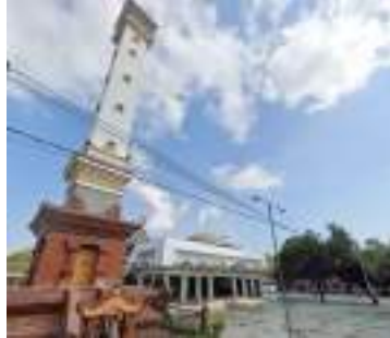
Kondisi Bangunan Masjid
